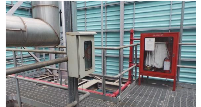
รูปที่ ค-13 การติดตั้งอุปกรณ์ดับเพลิงให้ครอบคลุมพื้นที่ต่างๆ ในโรงไฟฟ้า
